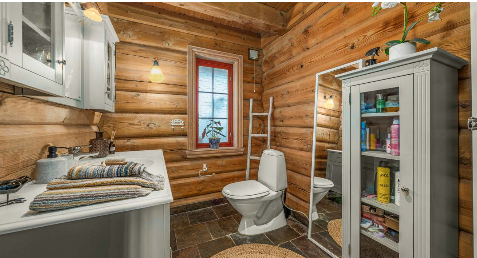
Tømmer på vegg og fliser på gulv.
