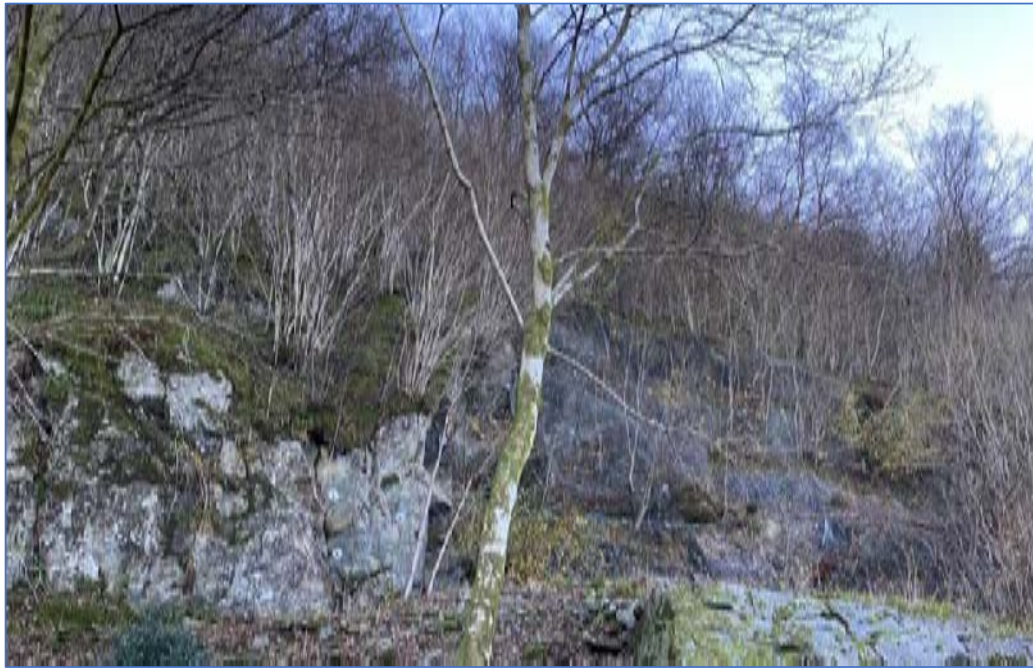
Bilde 2. Bolter og nett installert ovenfor Kolstiveien 79 A og B.
