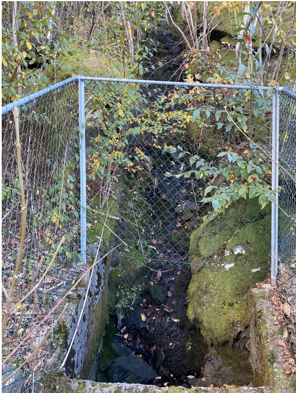
Figur 15. Bekk som går inn i kulvert ovenfor husrekke G/C.
