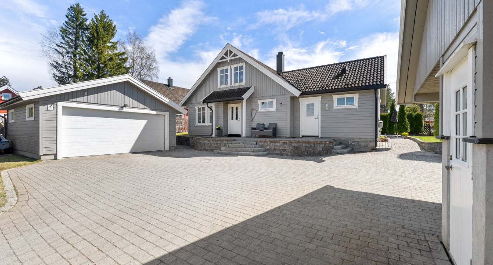
Romslig, opparbeidet gårdsplass foran boligen med belegningsstein og kantstein. Her er det godt med bilopptillingsmuligheter.
