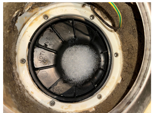
Plastsluk med klemring for membran
