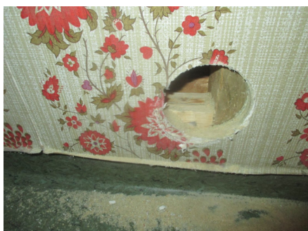
Hulltaking i vegg mot bad
