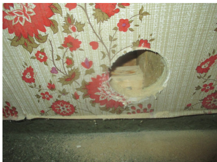
Hulltaking fra vaskerommet.
