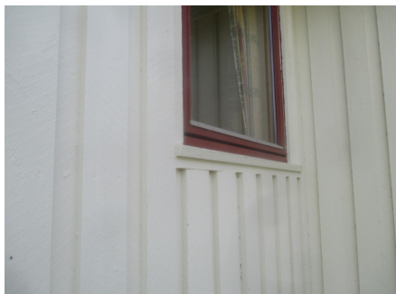
Deler av kledningen med tilhørende belistninger.
