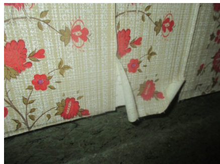
Tapet har løsnet flere plasser
