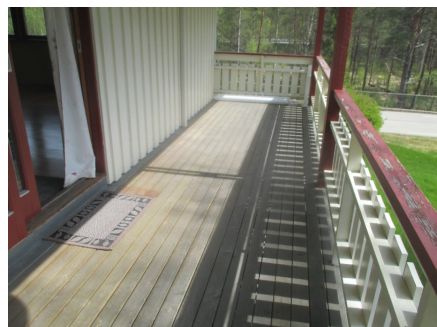
Deler av overbygget terrasse
