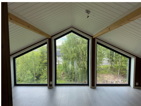
Mønet takkonstruksjon 2.etg
