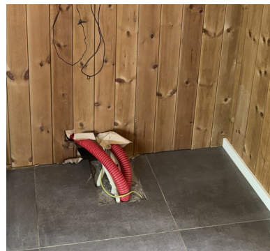
Veggpanel skåret vekk
