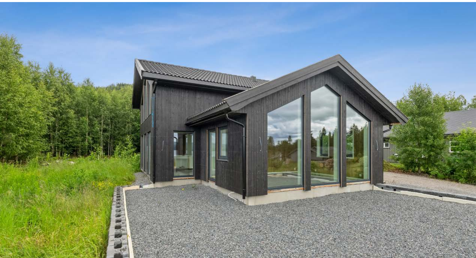
Det er påbegynt arbeide med å bygge en terrasseplattung.
