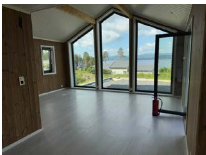
Mønet takkonstruksjon stue 1. etg.
