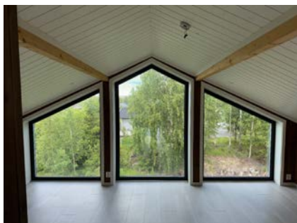
Mønet takkonstruksjon 2.etg
