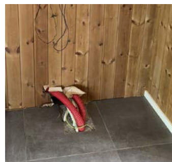
Veggpanel skåret vekk
