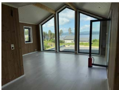
Mønet takkonstruksjon stue 1. etg.
