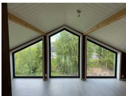
Mønet takkonstruksjon 2.etg
