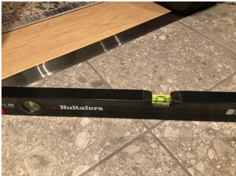
Hovedsakelig flat utførelse på gulv utenfor dusjsone
