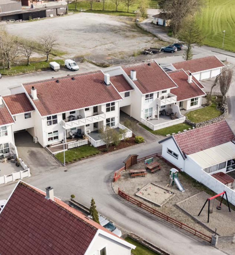
Fasade - Parkering i garasje
