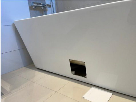
Inspeksjonslukke i badekar.
