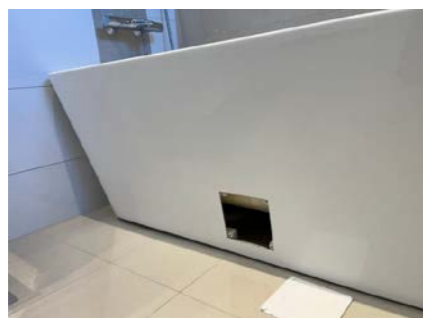
Inspeksjonsluke i badekar.
