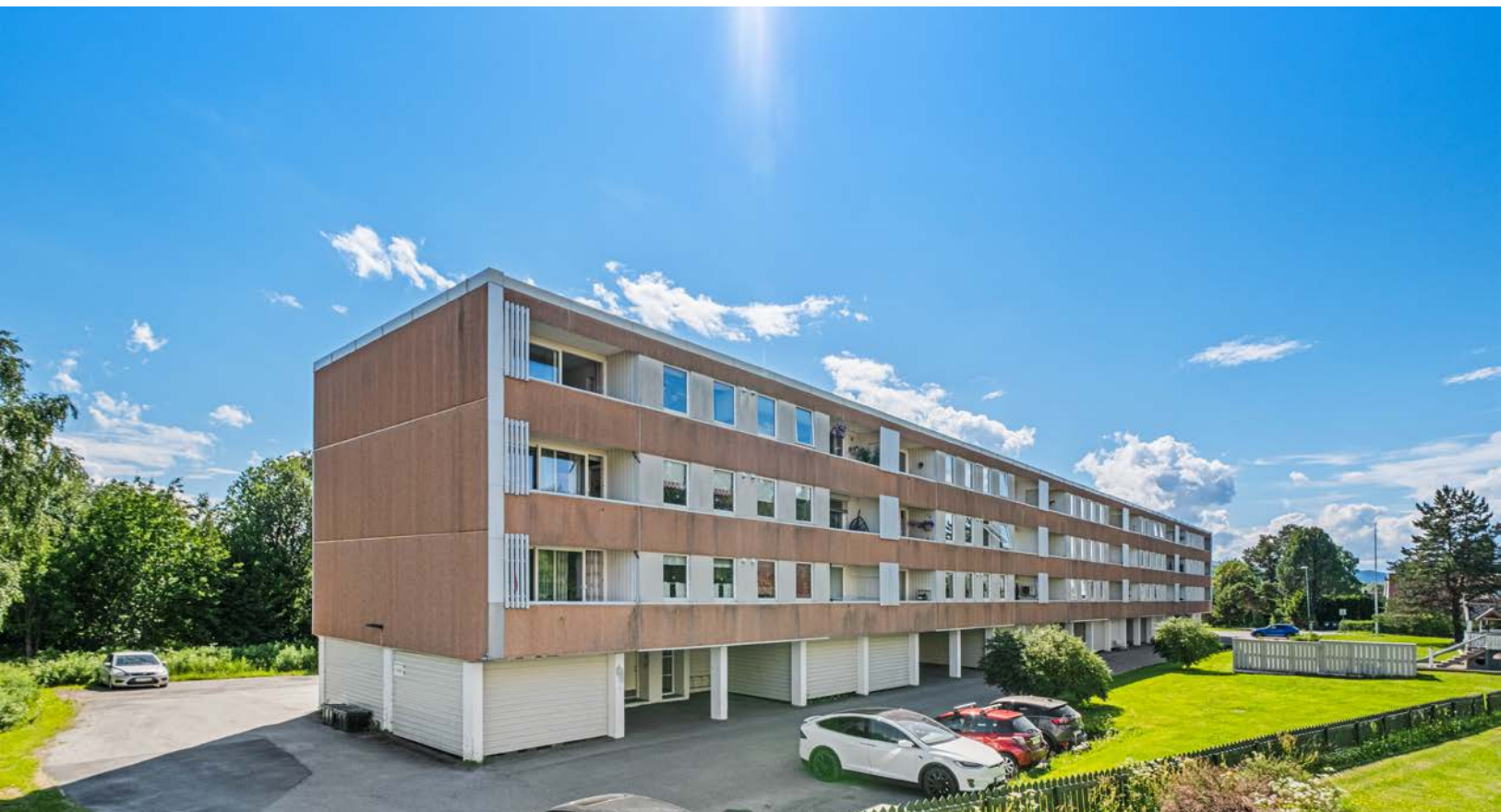
Av lagringsmuligheter har leiligheten en innvendig bod på 3,5 kvm og en ekstern bod på 1 kvm.
