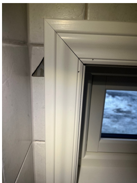
Malt trepanel i våtsoner til servant.
