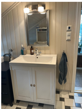
Malt trepanel i våtsoner til servant.
