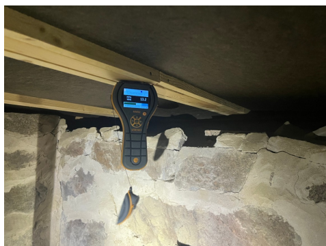
Fuktmåling viste normale forhold.
