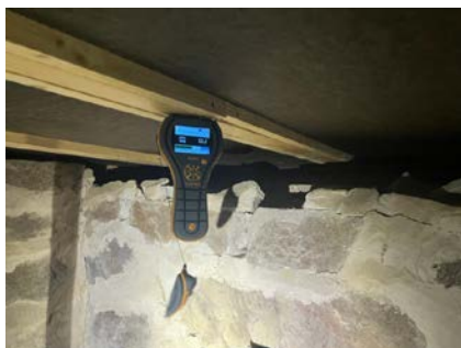
Fuktmåling viste normale forhold.
