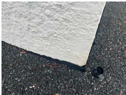
Synlig grunnmursplast uten klemlist.
