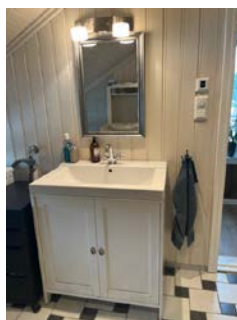
Malt trepanel i våtzone til servant.
