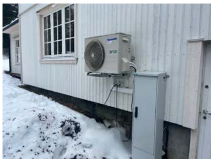
Utedel til varmepumpe.
