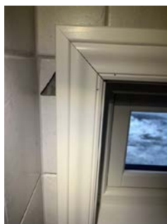
Malt trepanel i våtzone til servant.
