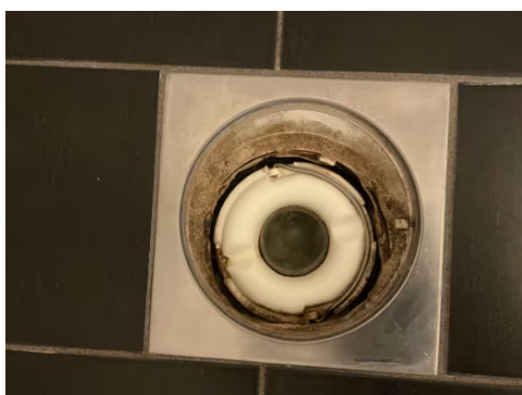
Plastsluk med synlig membran bak klemring.
