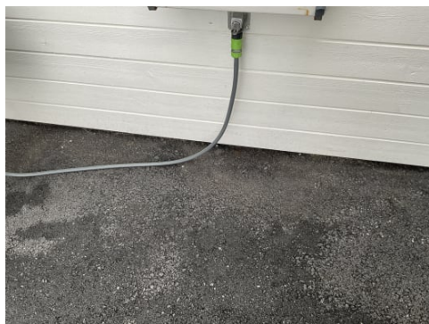
Bordkledning går stedvis nesten helt ned i terreng.
