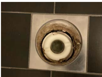
Plastsluk med synlig membran bak klemring.
