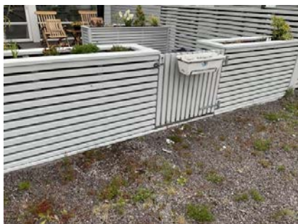
Treverk på terrasse er montert ned på terreng.
