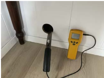
Resultat av fuktmåling viser under 7%
