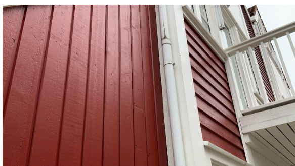
Del av vegg.
