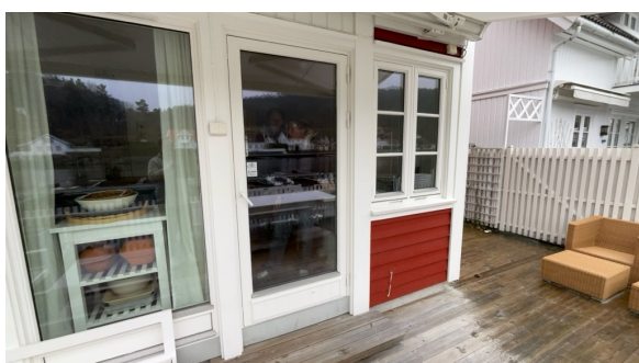
Terrassedør inn til kjøkken.
