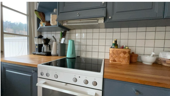
Montert avtrekk over komfyr.
