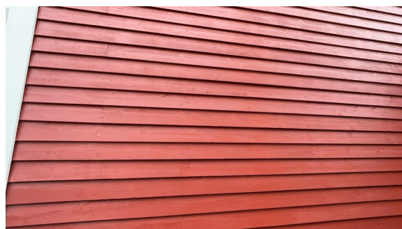
Del av vegg.
