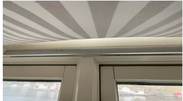
Eksempel på montert ventil i vindu.
