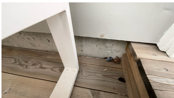
Del av grunnmur.
