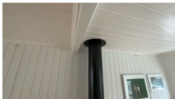
Del av pipe.
