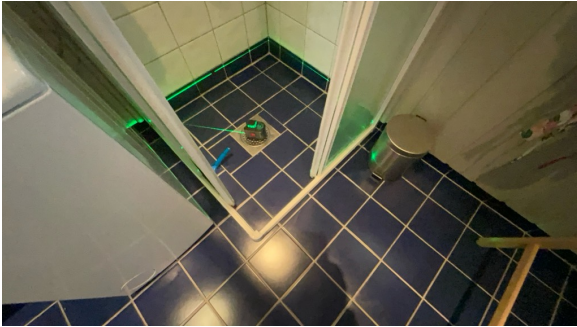
Målt fall på gulv. Del av gulv.
