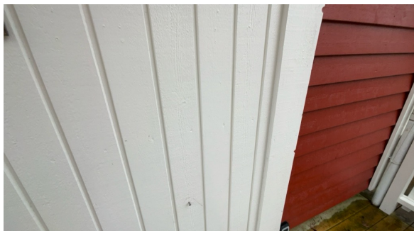
Del av vegg.
