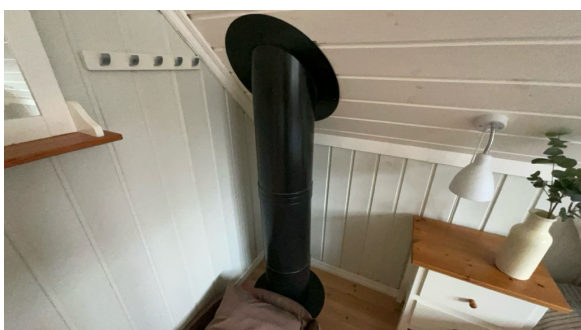
Del av pipe.
