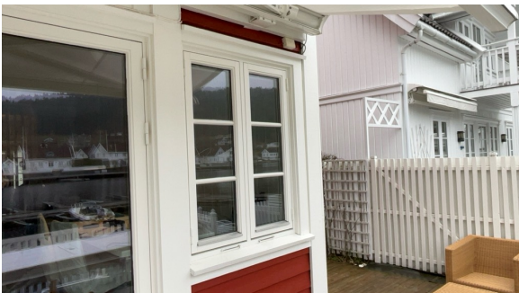
Eksempel på vindu i yttervegg.
