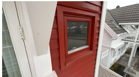
Eksempel på vindu i yttervegg.
