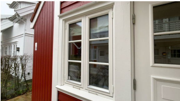
Eksempel på vindu i yttervegg.
