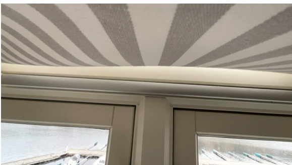
Eksempel på montert ventil i vindu.
