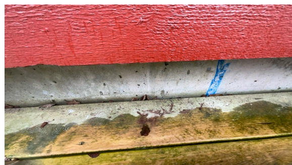
Del av grunnmur.
