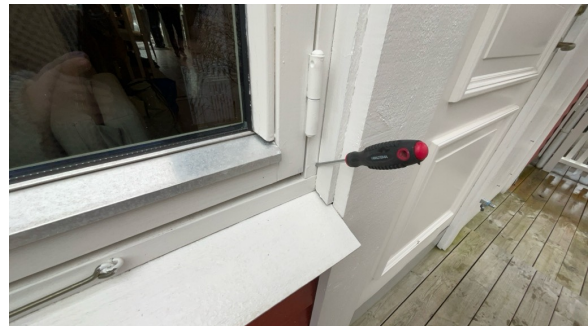
Stikk kontroll på vinduer er utført.
