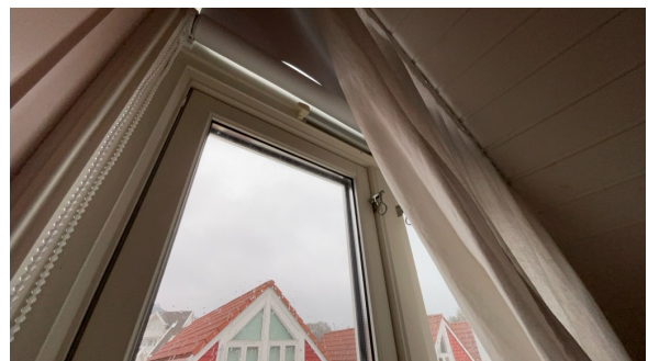
Eksempel på montert ventil i vindu.
