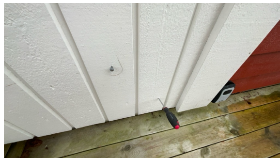
Stikk kontroll av vegger er utført.
