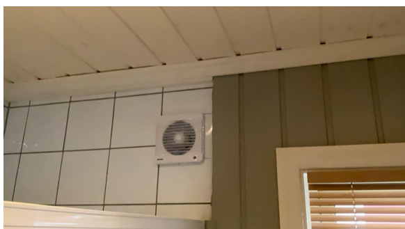
Montert avtrekk i vegg.
