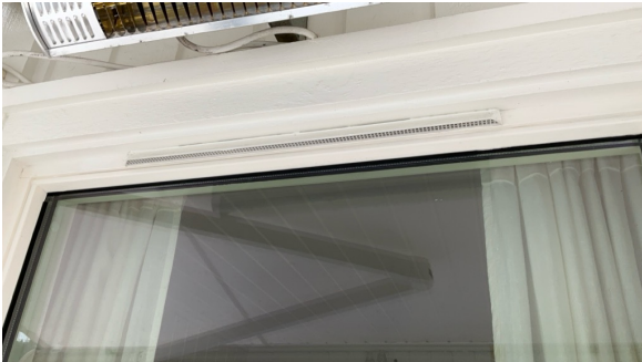
Eksempel på montert ventil i vindu.
