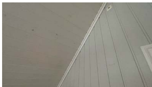
Del av vegg - tak.
