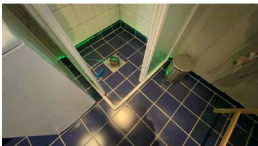
Målt fall på gulv. Del av gulv.
