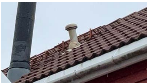
Del av taktekkning.
