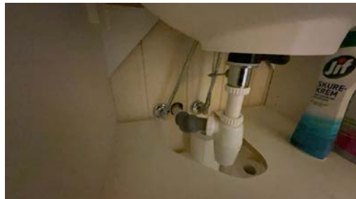
Del av rør til vann.
