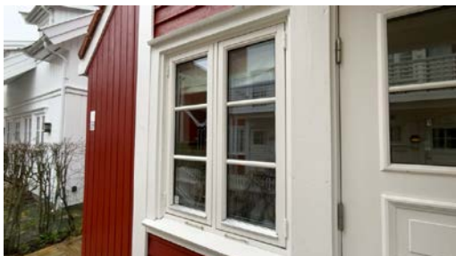
Eksempel på vindu i yttervegg.
