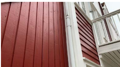
Del av vegg.
