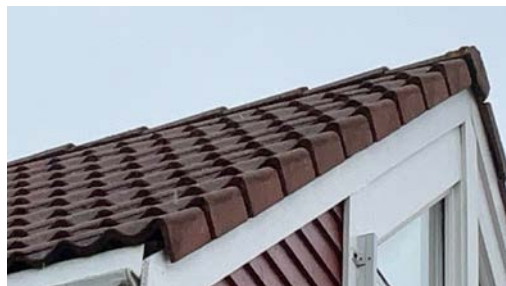
Del av taktekkning.
