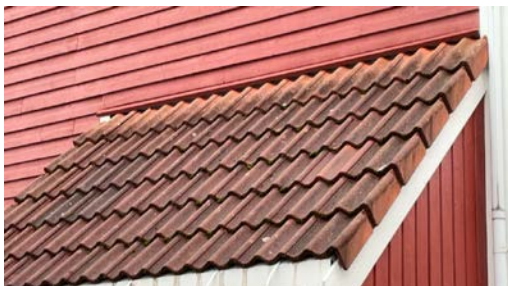
Del av taktekkning.
