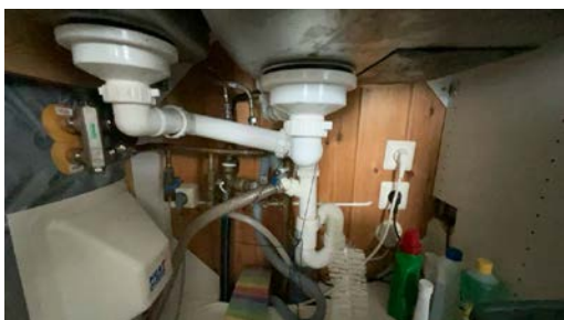
Del av rør til avløp.
