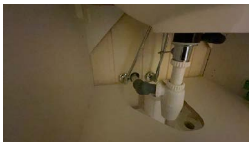
Del av rør til avløp.
