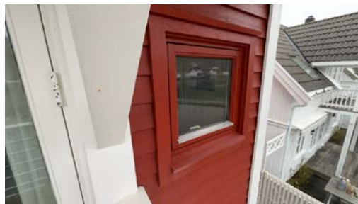
Eksempel på vindu i yttervegg.
