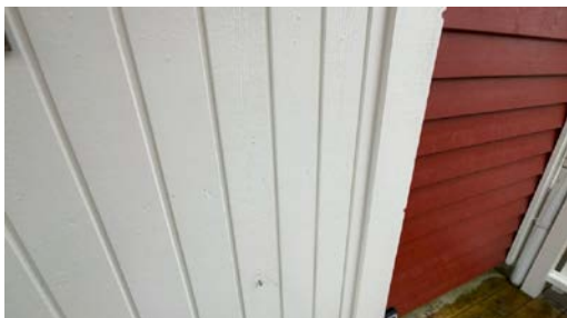
Del av vegg.
