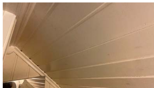
Del av toalettrom.
