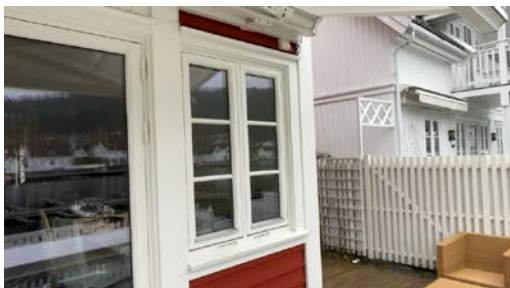
Eksempel på vindu i yttervegg.
