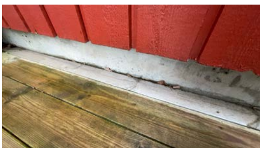
Del av grunnmur.
