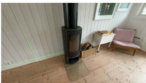
Montert ovn i stue.
