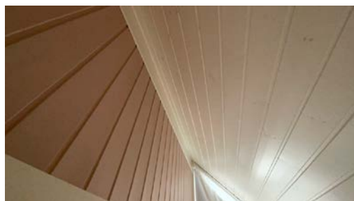
Konstruksjon sett fra 3 etasje.
