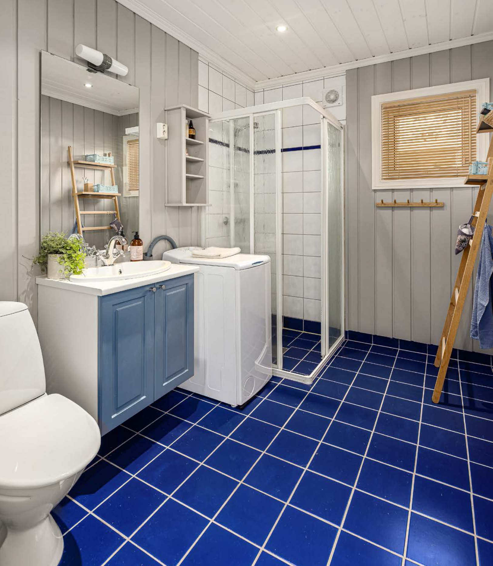
Badet har flislagt gulv med varmekabler og malt panel på vegger (flis i dusjsone). Rommet inneholder servant med skap, dusjhjørne, wc og opplegg for vaskemaskin.
