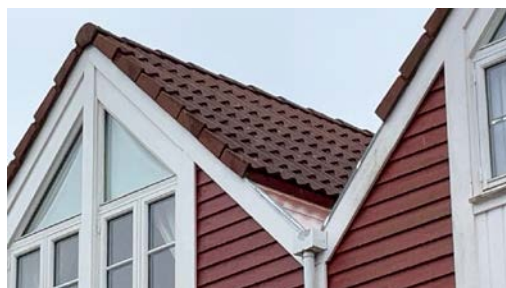
Del av taktekkning.
