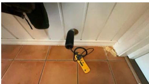
Hull for kontroll av fukt.
