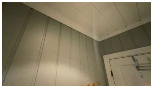
Del av vegg - tak.
