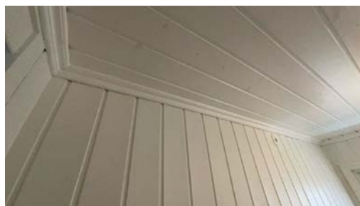
Del av vegg - tak.
