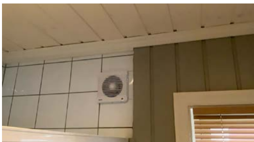
Montert avtrekk i vegg.
