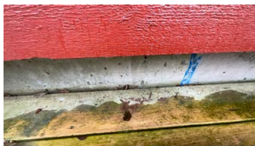
Del av grunnmur.
