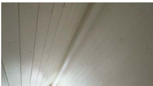
Konstruksjon sett fra 3 etasje.
