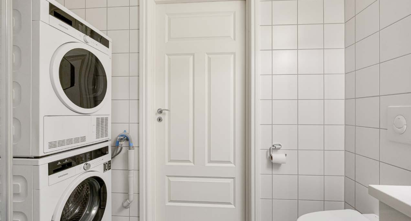
Opplegg for vaskemaskin er etablert på badet.
