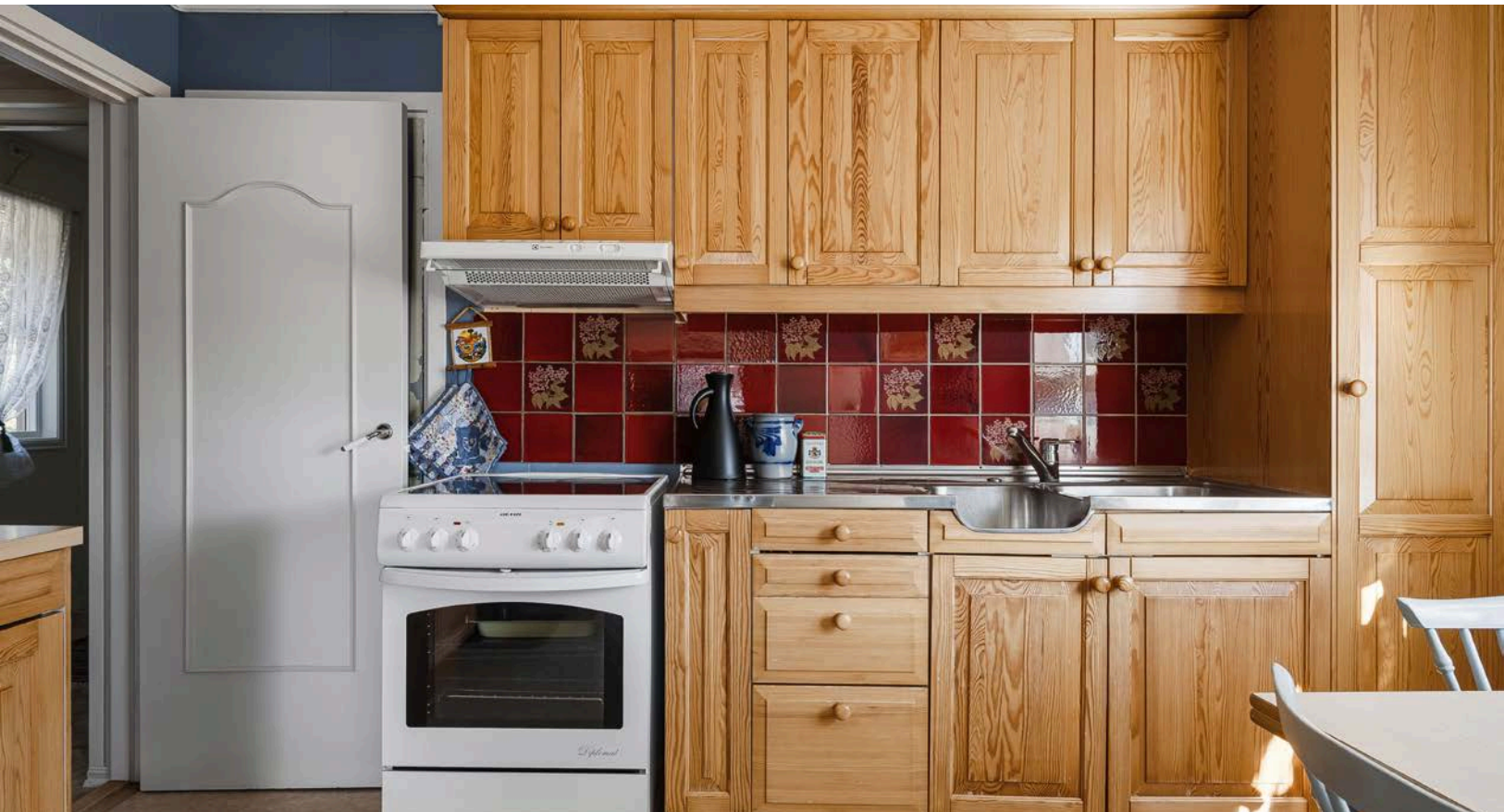
Danica kjøkkeninnredning fra 1986 med god skaplass. Innredningen har profilerte fronter, laminert benkeplate, benkebeslag med nedfelt oppvaskkum og fliser i benkeryggen.
