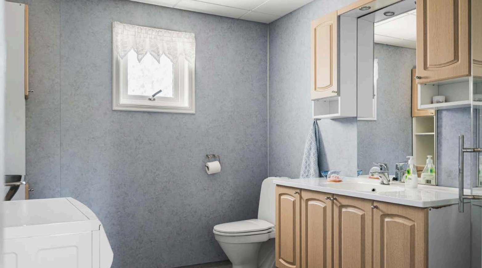
Eldre, men velfungerende baderom i 1. etasje med våtromsbelegg på gulv, våtromsplater på veggene og downlights i himlingen. Det er også plass og opplegg for vaskemaskin.
