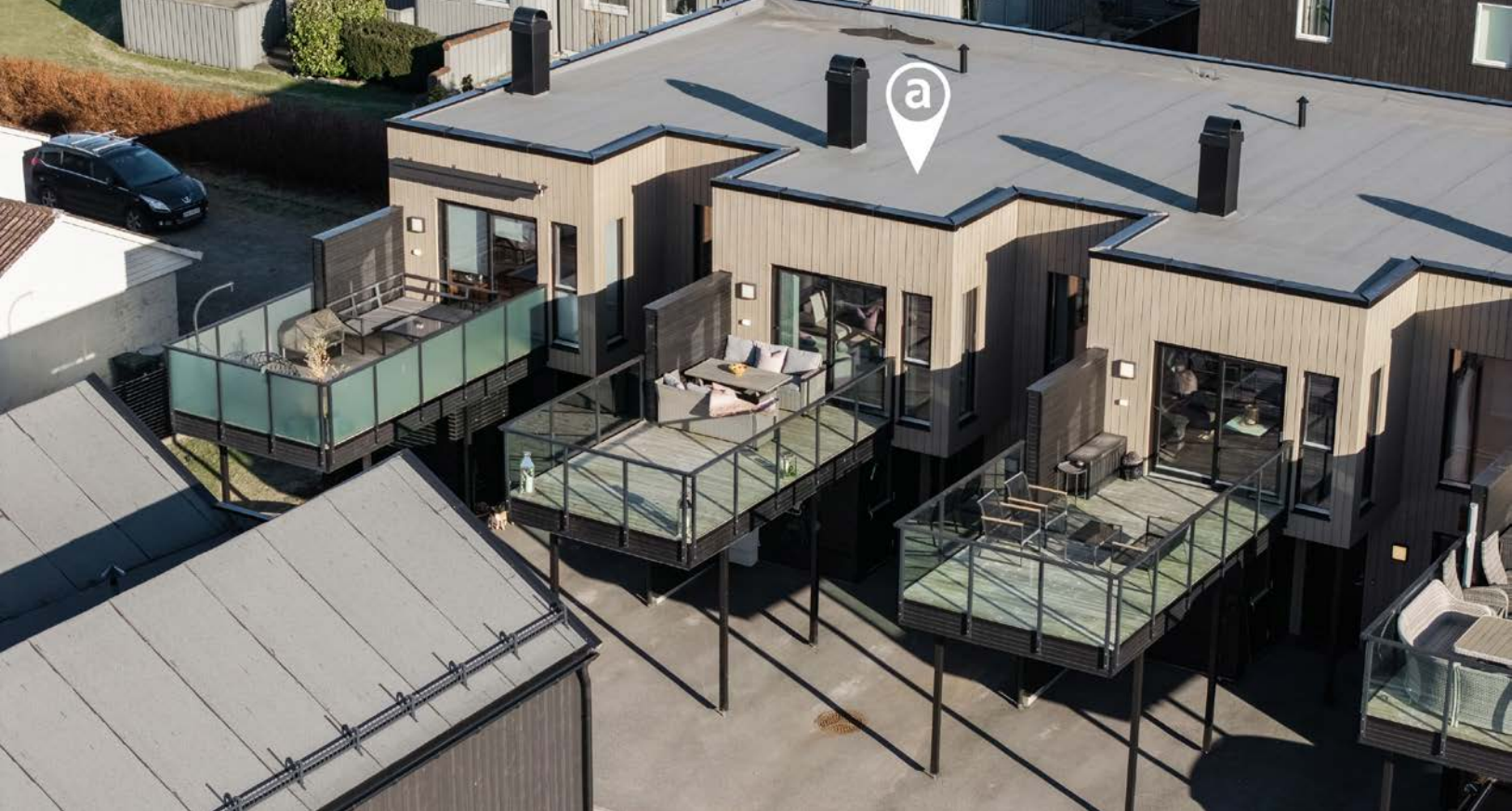
Biloppstillingsplass med tomt og i carport med installert elbillader.
