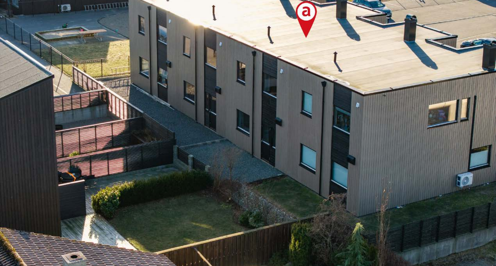
Opparbeidet, singelbelagt område bak boligen.
