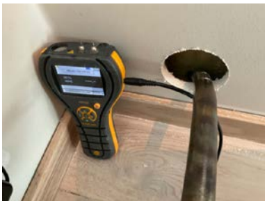
Fuktmåling i vegg ved hulltaking.
