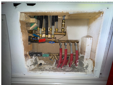
Inspeksjonsluke i tilstøtende bod
