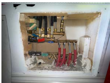
Inspeksjonsluke i tilstøtende bod
