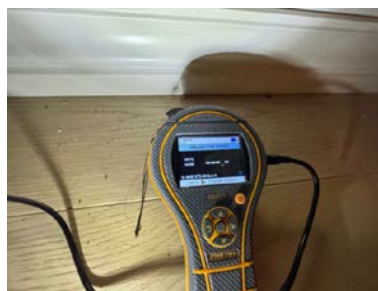
Fuksøk med pigger i treverk
