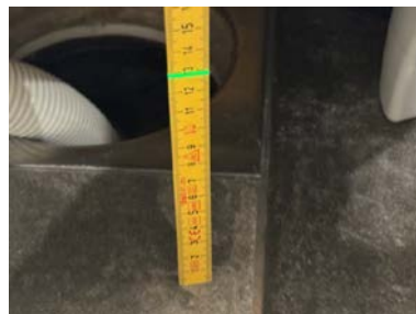
Fallforhold ca. 129 mm overkant gulv foran badekar (ved sluk)
