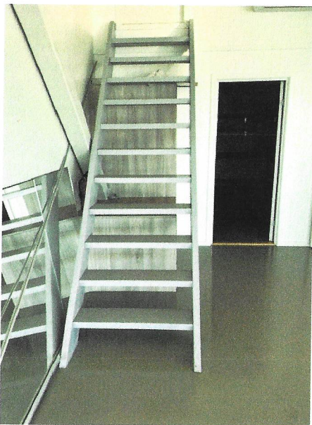
Trapp i tre til teknisk rom.
