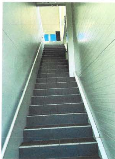
Trapp mellom 1. etg. og 2. etg.
