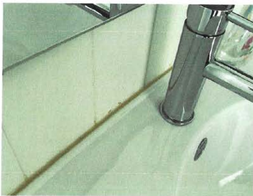
Fuktskade i veggplate ved vask på toalett rom. Toalett rom.
