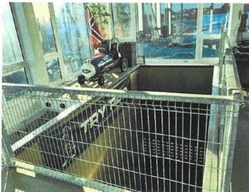
Rekkverk rundt utsparing til løfteplattform.
