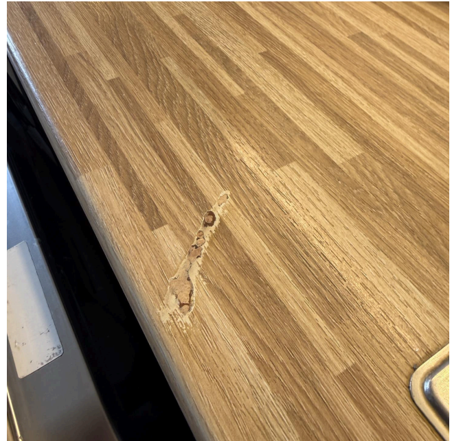
Skade i benkeplate
