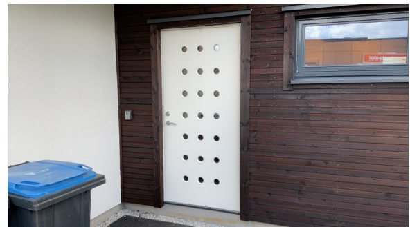
Dør til vaskerom
