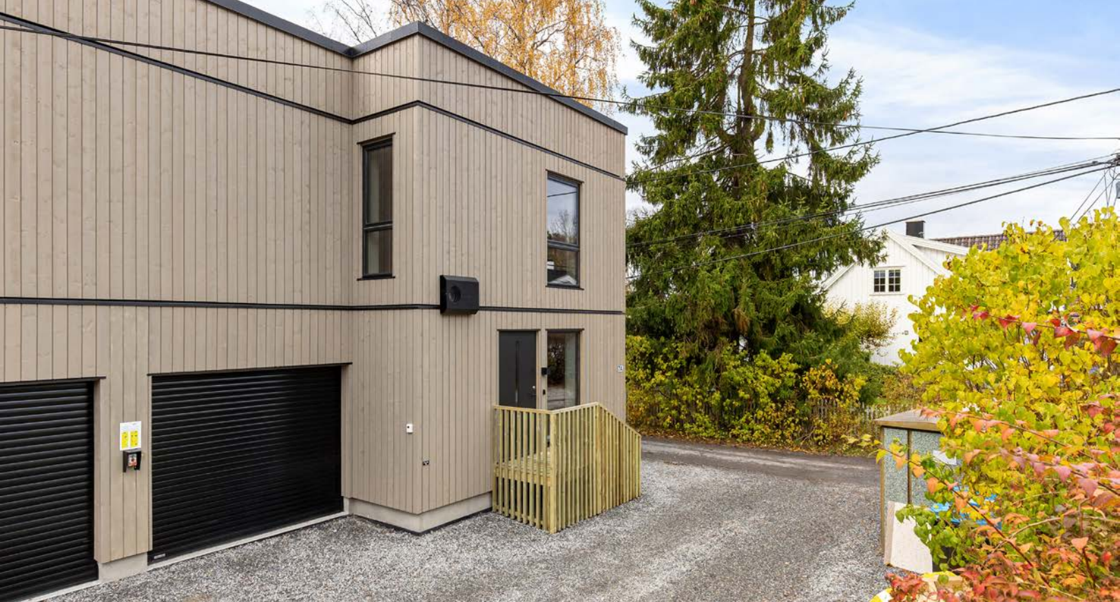
Fasade på baksiden med inngangsparti og garasje
