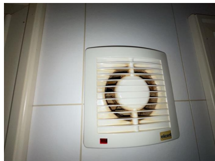
Mekanisk avtrekksvifte
