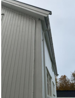
Ingen synlig ventilering i raftekaske ved overgang tak/vegg
