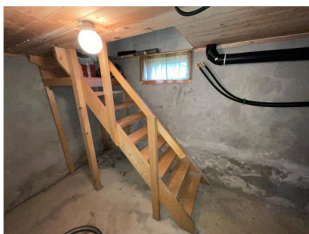
Trapp sett fra kjeller
