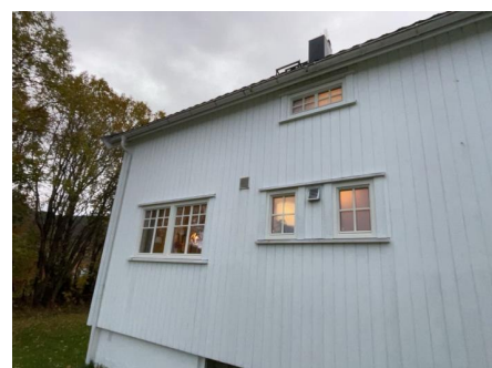
Vinduer på kjøkken og våtrom
