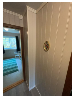
Pipe er kledd inn mot gang i 2. etasje med panelplater
