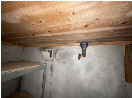
Fuktmåling i bjelkelag
