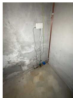
Vannstopventil uten strømtilførsel
