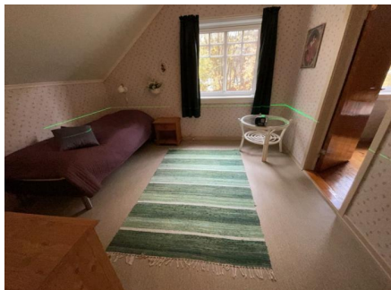
2. etasje Plassering av laser ved kontroll av soverom 1. Det er målt 9 mm høydeforskjell gjennom rommet. TG 1
