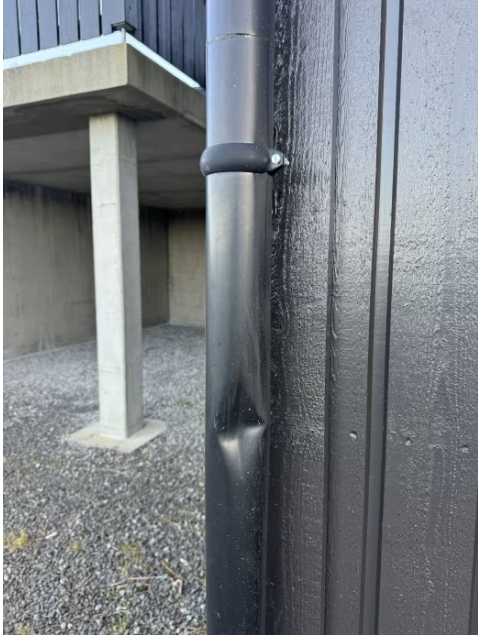
Skadet nedløpsrør.
