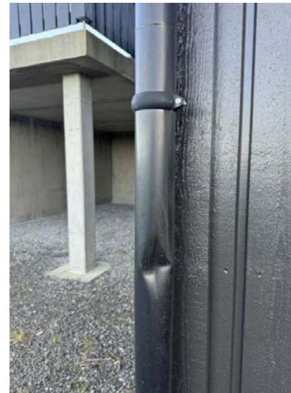
Skadet nedløpsrør.
