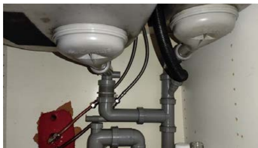
Kontroll av røropplegg.
