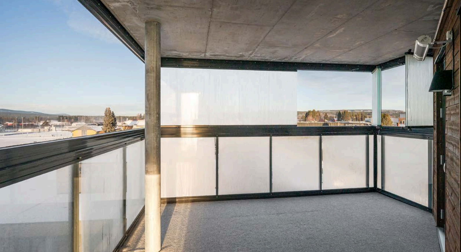
Balkongen er overbygget, har teppe på gulv og rekkverk med glassfelt og glassfelt som kan skyves til siden. Det er også montert varmelampe, utebelysning og stikkontakt.
