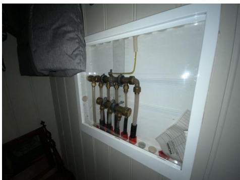
Besiktigelse av røropplegg.
