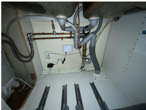
Besiktigelse av røropplegg.
