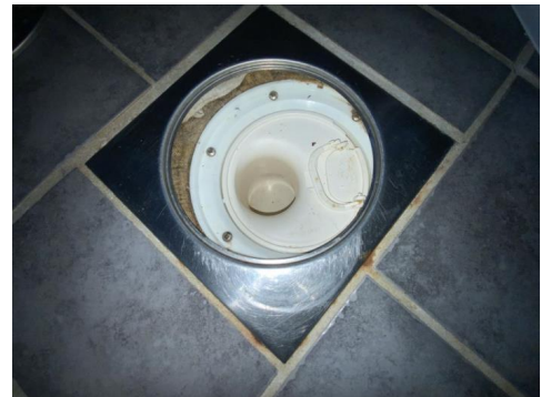
Kontroll av sluk.
