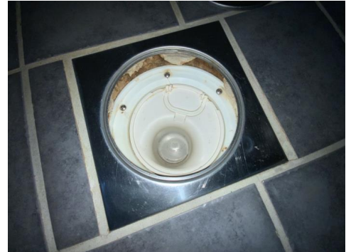
Kontroll av sluk.
