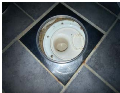
Kontroll av sluk.
