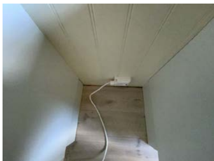
Kontroll bak ovn. Ingen tegn til fuktskader på befaringdagen.
