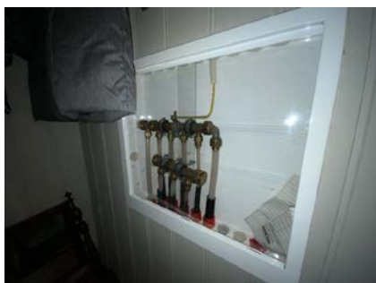
Besiktigelse av røropplegg.
