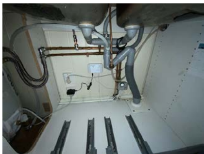
Besiktigelse av røropplegg.
