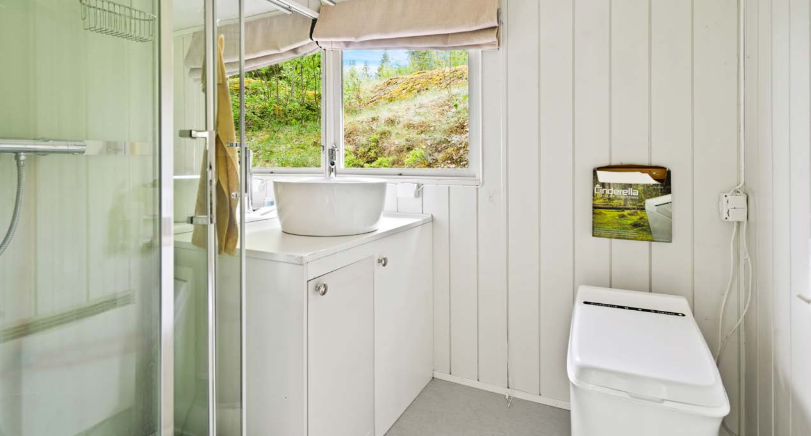
Badet er innredet med servantskap, dusjkabinett og Cinderella forbrenningstolett.
