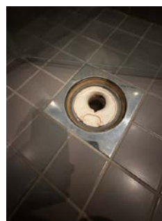
Plastsluk med klemring for membran
