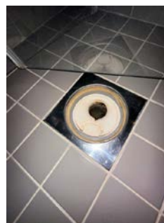
Plastsluk med klemring for membran
