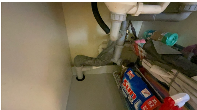
Besiktigelse av røropplegg.
