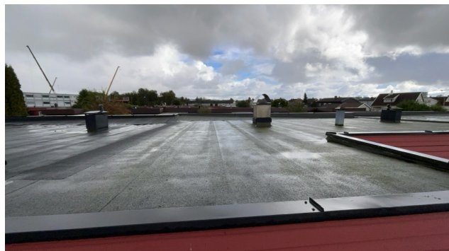
Besiktigelse av taktekke.
