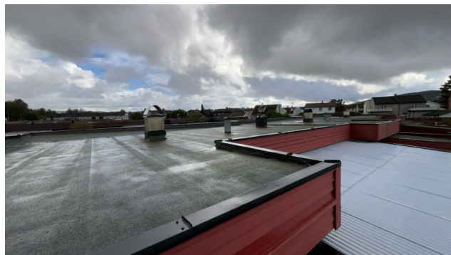
Besiktigelse av taktekke.
