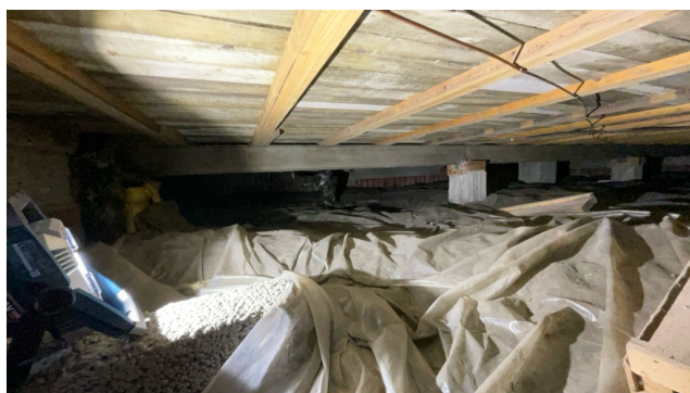
Besiktigelse av kryprom.
