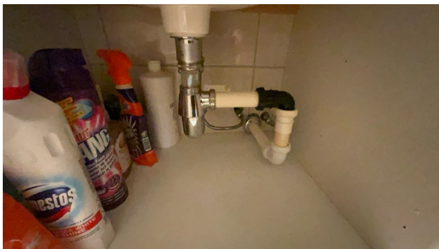
Besiktigelse av røropplegg.
