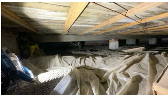
Besiktigelse av krypprom.
