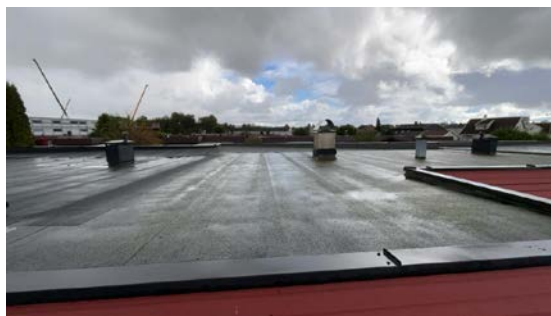
Besiktigelse av taktekke.
