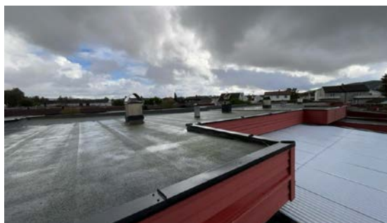
Besiktigelse av taktekke.
