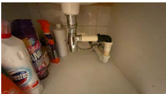
Besiktigelse av røropplegg.
