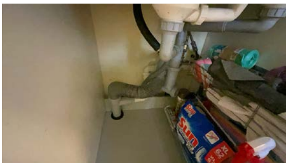
Besiktigelse av røropplegg.
