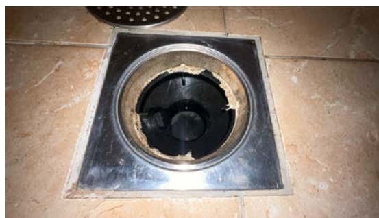
Kontroll av sluk.
