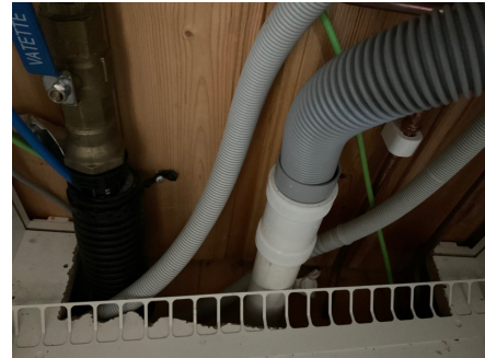
Avløpsrør i kjøkkenbenk
