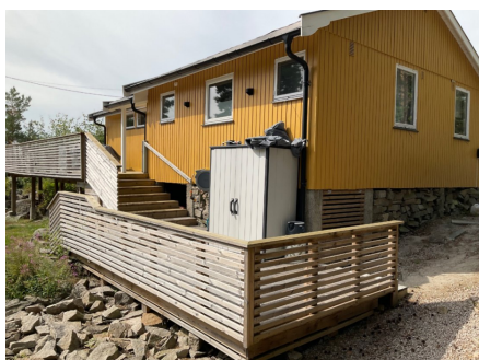
Trapp ved nedgang fra inngangsparti med vindfang
