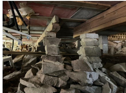
Underside av bjelkelag med understøtte av bjelker og fundamenter av naturstein
