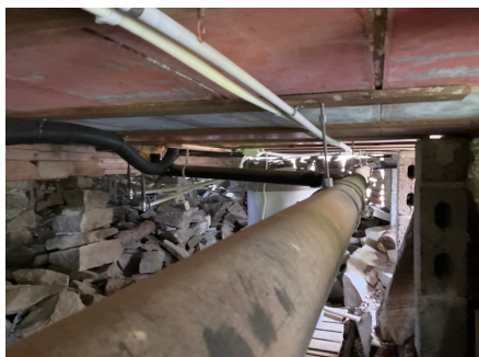
Vannrør ført under bjelkelag i åpent kryperom
