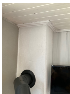
Fullbeslått pipe på tak med plate og luftspjeld
