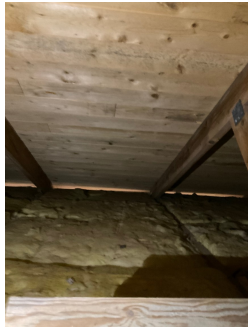
Undertak _ isolasjon på bjelkelag _ lufting ved raft
