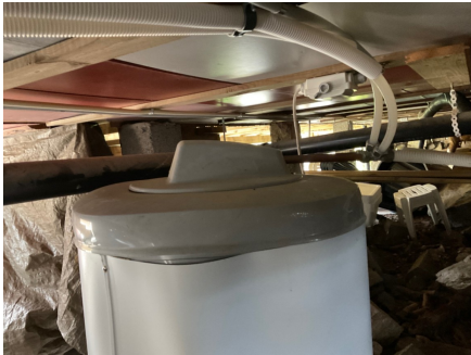
Utbulning av ytre del på berederen
