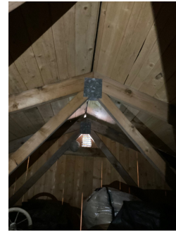
Undertak _ takstoler _ lufting ved gavl
