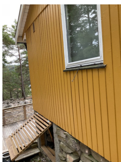
Grunnmur med naturstein og støpte lettbetongelementer
