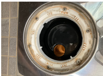
Vannlåsinnsett / kopp til å trekke opp for rens av sluk
