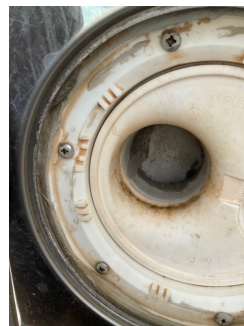
Synlig mansjett med påført smøremembran
