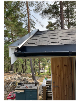
Shingel på taket, takrenner og nedløpsrør av stål
