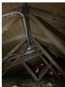
Undertak _ isolasjon på bjelkelag _ lufting ved raft
