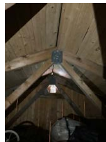
Undertak _ takstoler _ lufting ved gavl
