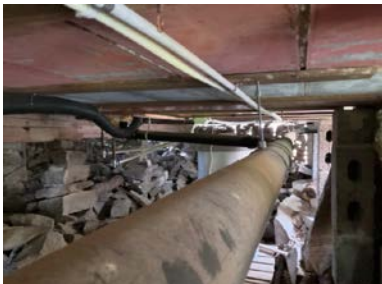
Vannrør ført under bjelkelag i åpent kryperom
