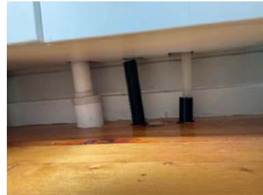
- Vannrør ført til servant fra åpent kryperom - Avløpsrør ført fra servant til åpent kryperom
