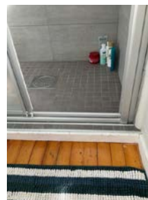
Kant med skyvedør til dusjnise
