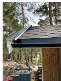
Shingel på taket, takrenner og nedløpsrør av stål
