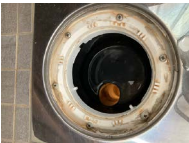
Vannlåsinnsats / kopp til å trekke opp for rens av sluk
