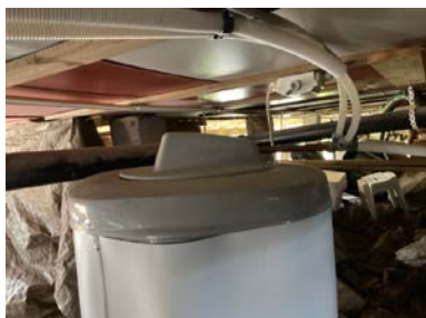
Utbulning av ytre del på berederen
