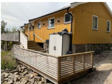
Trapp ved nedgang fra inngangsparti med vindfang
