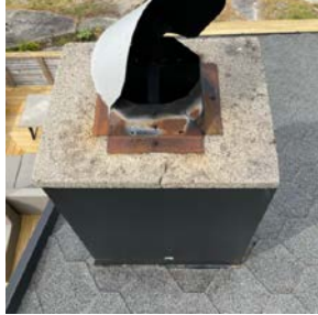
Fullbeslått pipe på tak med plate og luftspjeld
