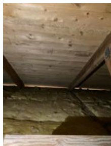
Undertak _ isolasjon på bjelkelag _ lufting ved raft
