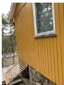
Grunnmur med naturstein og støpte lettbetongelementer
