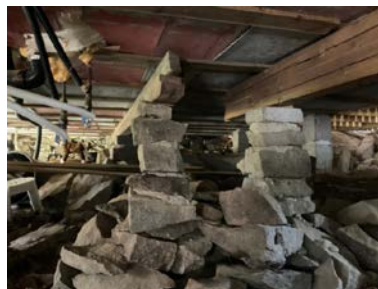
Underside av bjelkelag med understøtte av bjelker og fundamenter av naturstein
