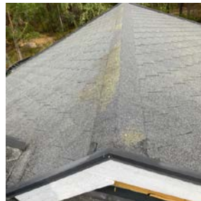
Møne og takflate del mot nord-øst
