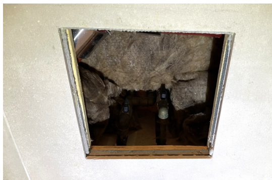
Hovedrør inn til leiligheten er i kobber.
