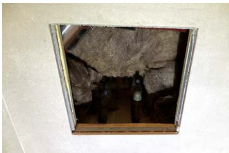
Hovedrør inn til leiligheten er i kobber.
