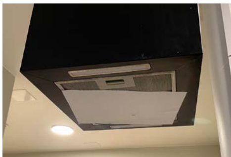
Ventilator bestod papirtesten
