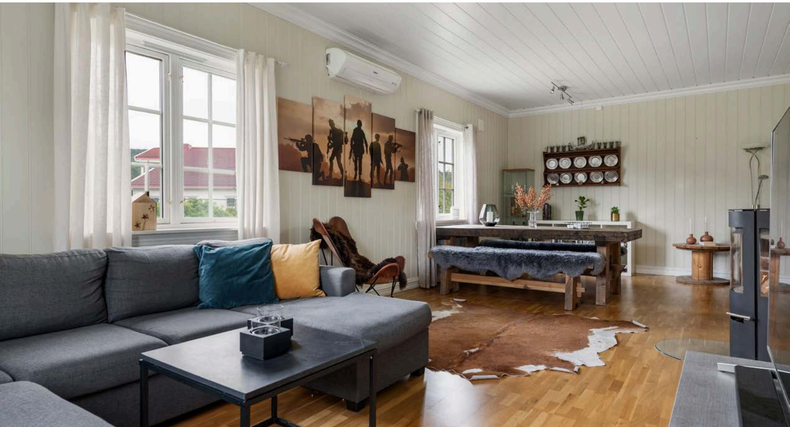
Det er montert luft-til-luft varmepumpe som sørger for en god og jevn varme på vinterstid.
