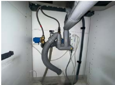
Røropplegg i kjøkkenbenk med Waterguard
