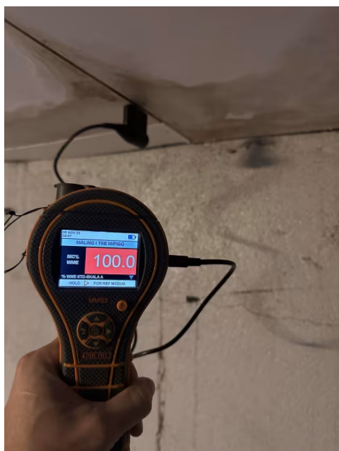
Fuktmåling i grovkjeller tak (under stue)
