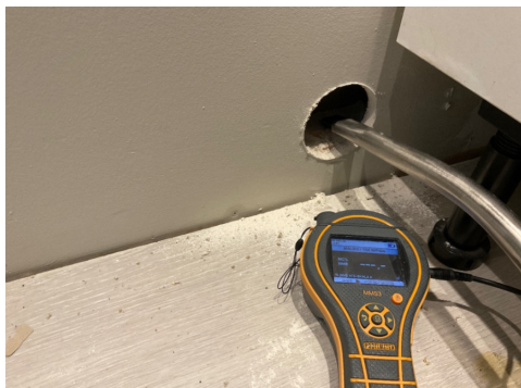
Hulltaking på kjøkken mot baderom
