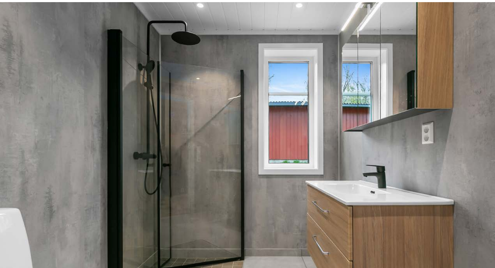
Badet har flislagt gulv, våtromsplater på vegger og mdf-himling med innfelt spotbelysning
