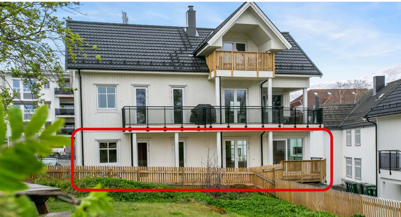
Ny og romslig leilighet i 1. etasje i tomannsbolig i Sameiet Aunelund
